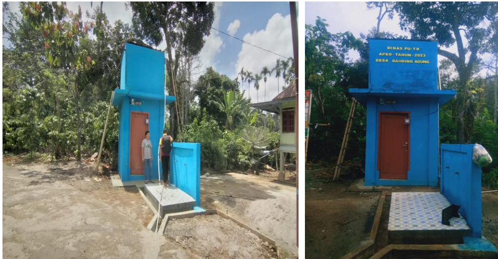
Gambar 3.2 Foto Pembangunan Sumur Bor Dusun III Desa Banding Agung Kecamatan Banding Agung
