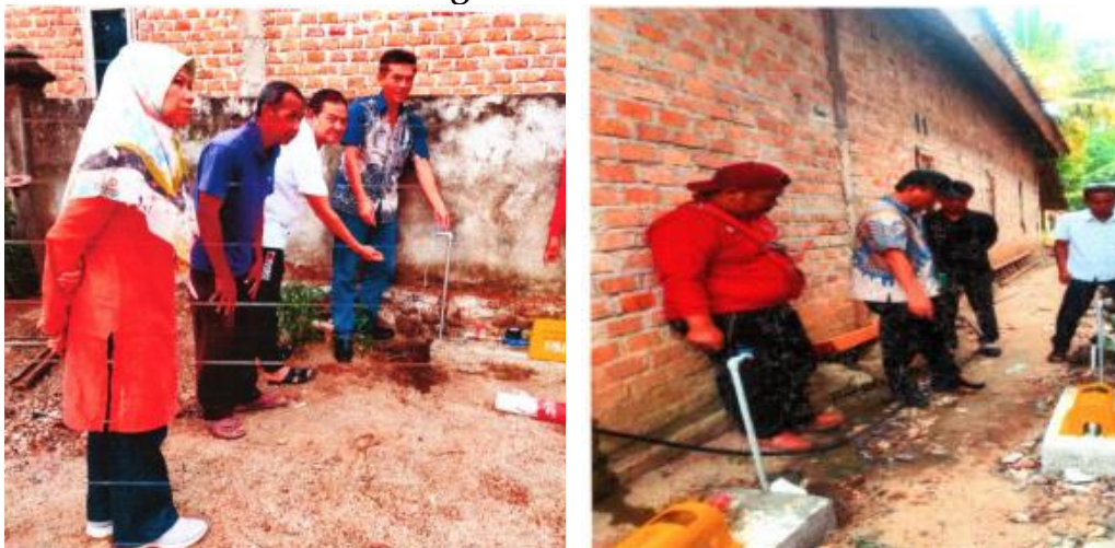
Gambar 3.4 Pemasangan Hibah Air Minum Pedesaan
