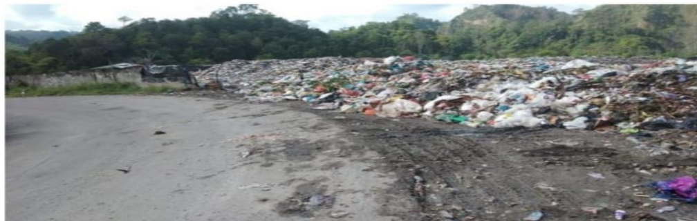
Posisi TPA bendi persis dibahu jalan lintas sesekali tercecer ke badan jalan
